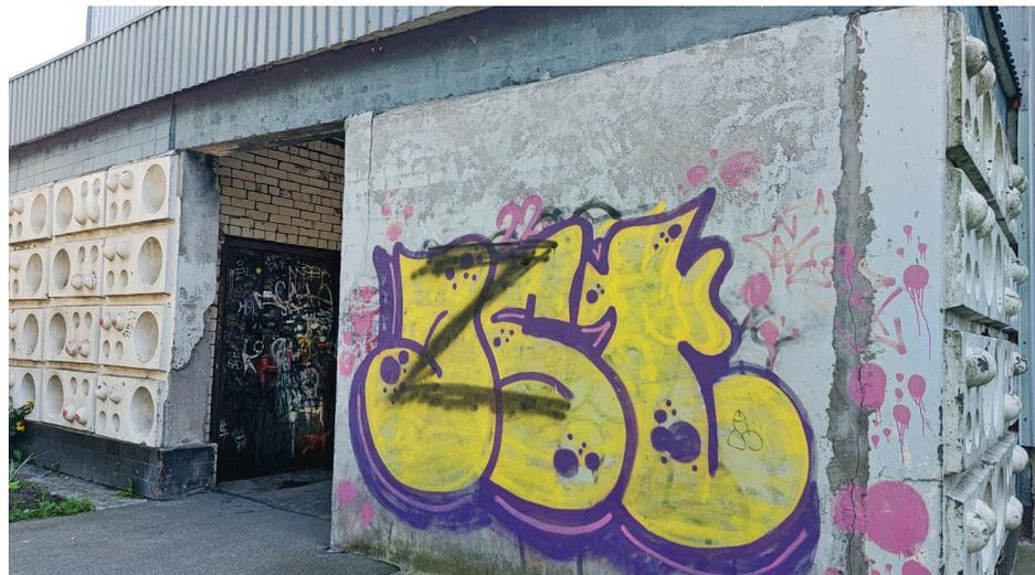
RNP приобрел специальное устройство для очистки стен струей сухого песка. Используем и другие варианты, например, моем стены руками или при помощи разных химикатов. Для профилактики стены дома можно покрывать особым составом, с которого потом проще смывать надписи, не повреждая сами стены.
