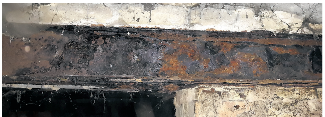
Балки подвала до и после ремонта.
