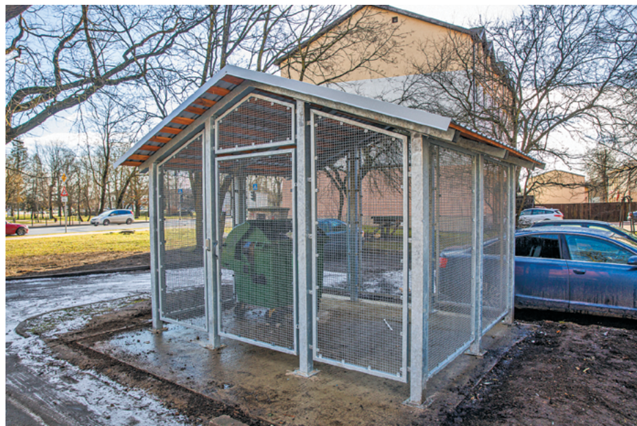
В Елгаве самоуправление разработало типовой проект закрытой мусорной площадки. Образцовая площадка у дома по ул. Паста, 44
