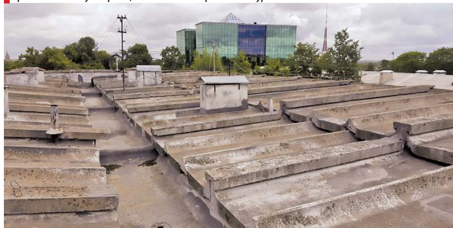
Крыша в доме по ул. Гарозес, 19 до и после покрытия полиуретаном
