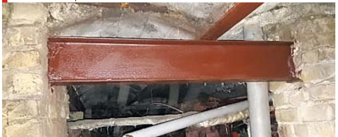
Балки подвала до и после ремонта.
